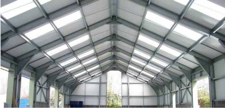
Hình 2. Khung dầm thép nhà công nghiệp (nguồn: khung kèo thép nhà công nghiệp.vn)
