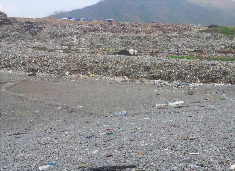
Hình 3.13 – Rác tại ô chôn lấp số 3
