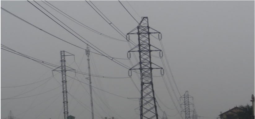
Hình 4.1. Đường dây mạch kép 200kV phân pha
