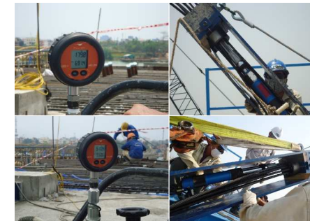
Hình 2.3: Điều chỉnh nội lực bằng cách căng kéo dây văng
