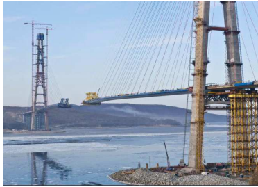
Hình 1.10: Cầu dây văng thi công theo phương pháp đúc hẫng
