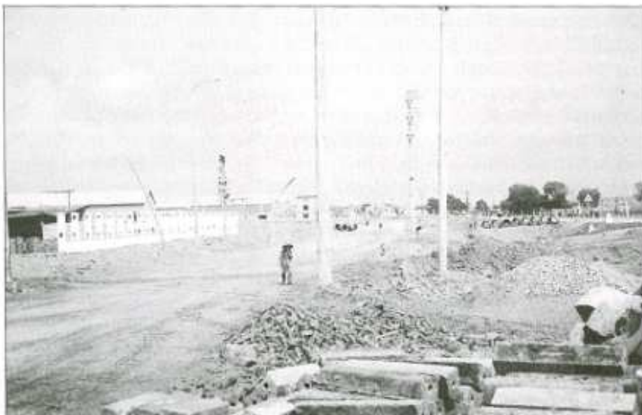
Xây dựng hạ tầng KCN Quế Võ (Bắc Ninh)
